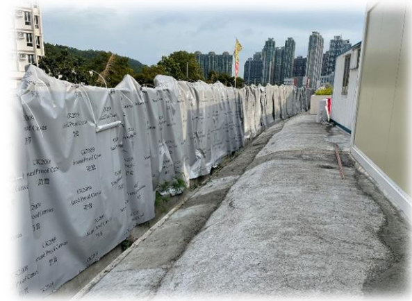
在靠近民居地盤邊界設置隔音屏障
