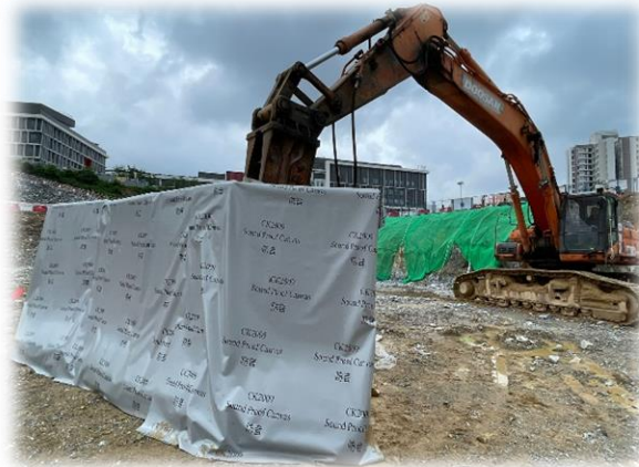
設置流動隔音屏障
