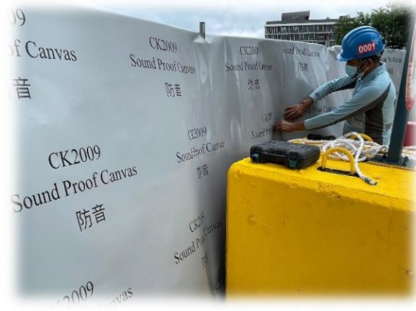
在打炮區域設置隔音屏障
