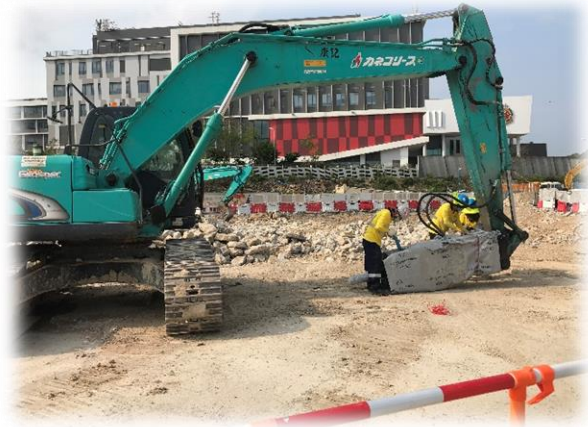
所有炮機使用隔音物料包妥炮頭
