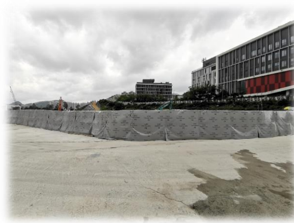
在打炮區域設置隔音屏障
