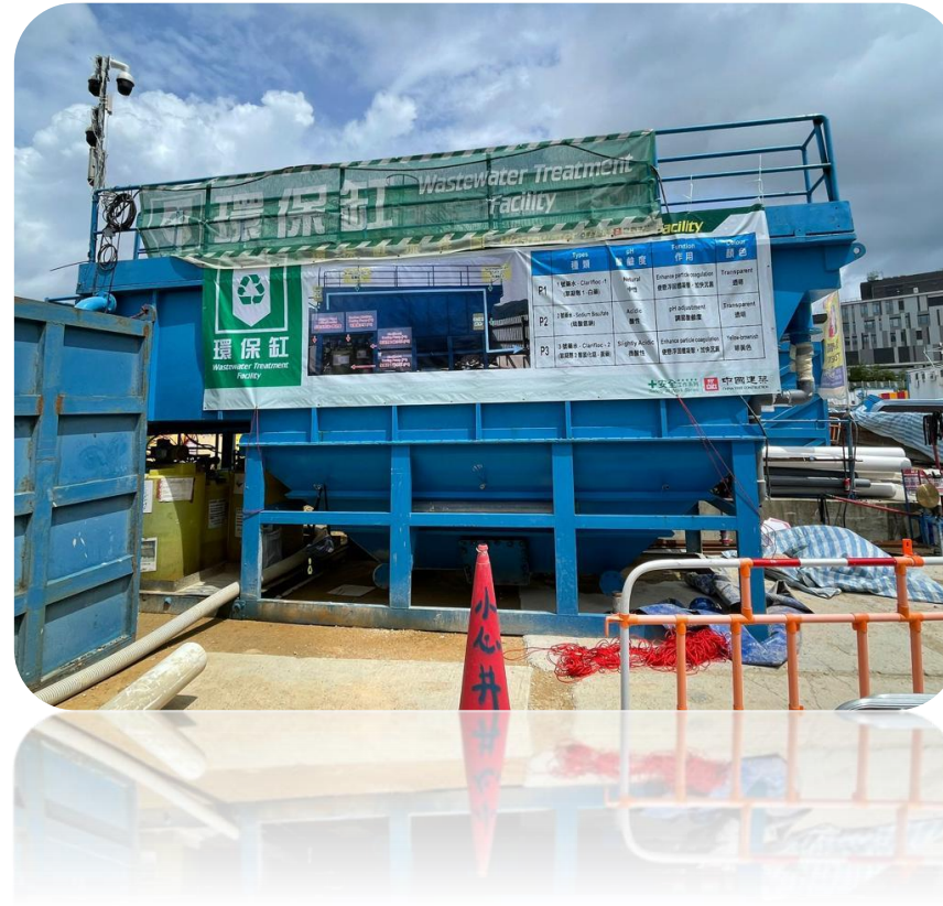
設置三台污水處理設施處理地盤產生的污水。
